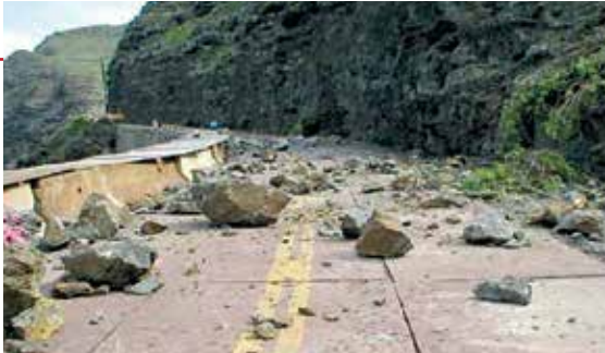
Gegaran gempa bumi dan getaran daripada letupan batu cerun Earthquake tremors and vibrations from rock blasting
