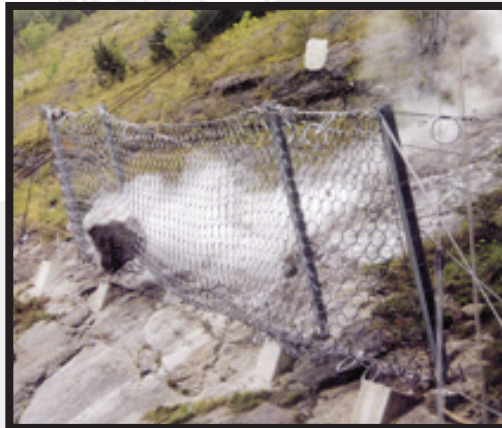
Contoh langkah kejuruteraan bagi cerun batuan semulajadi menggunakan kaedah rockfall fence / barrier
