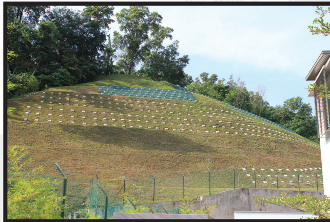
Contoh cerun tanah dengan langkah kejuruteraan yang diperkukuhkan dengan 'soil nail'
