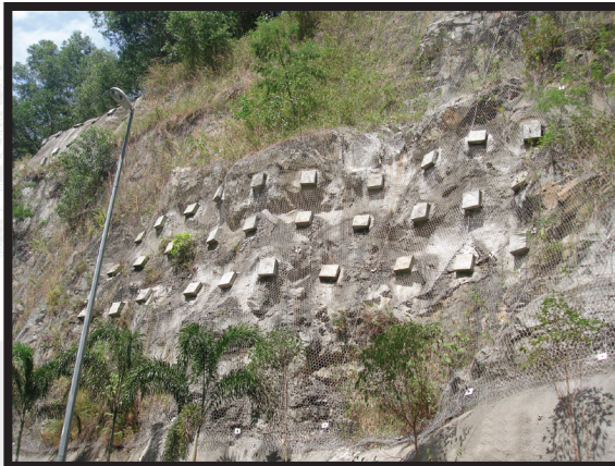
Contoh langkah kejuteraan bagi cerun batuan semulajadi yang diperkukuhkan dengan kaedah 'rockbolt'.
