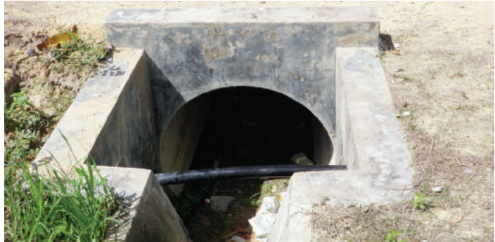
Gambar 5.5: Perangkap kelodak dapat mengurangkan pemendapan kelodak di sungai berdekatan dengan ladang.
