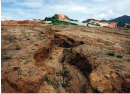
Gambar 1.1: Tanah yang dibangunkan di kawasan tanah bercerun tanpa mengikut panduan akan mengakibatkan hakisan yang serius.
