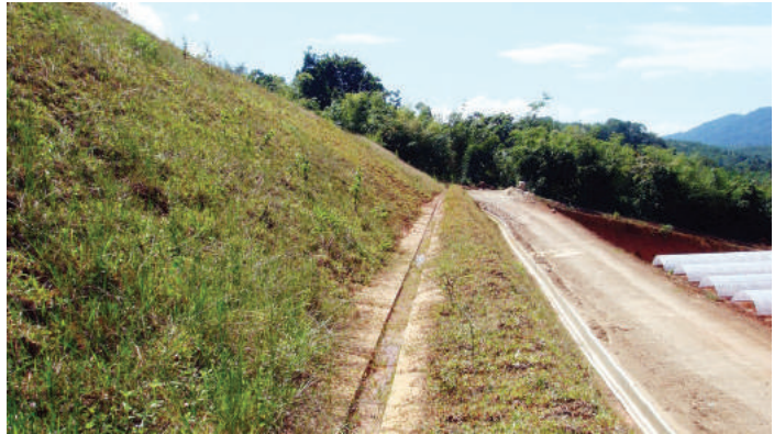
Gambar 5.3: Parit lereng yang dibina di sebelah jalan masuk ke sebuah ladang.
