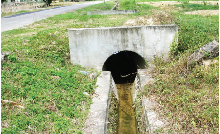
Gambar 5.10: Pembetung yang dibina di laluan masuk ke ladang.
