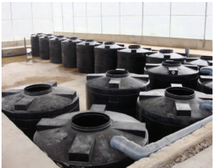
Gambar 1.7: Sistem penuaian dan kitar semula air hujan.
