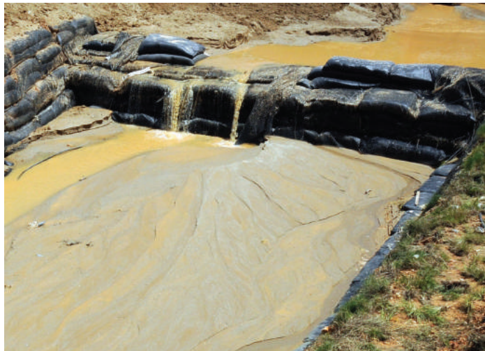
Gambar 5.7: Empangan penampungan yang dibina untuk memerangkap kelodak.
