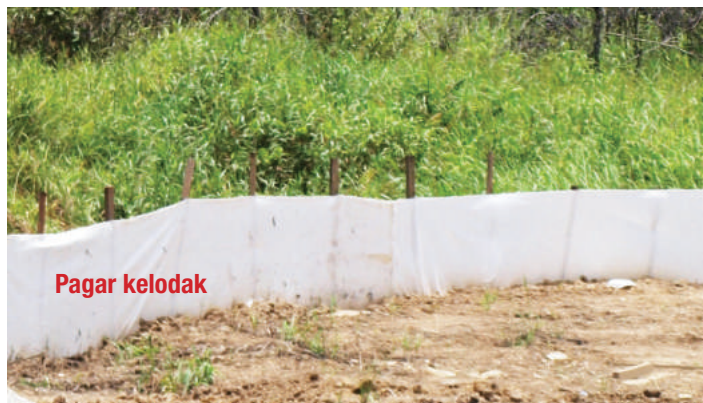
Gambar 5.4: Pagar kelodak yang dibina di kawasan baharu dibuka.
